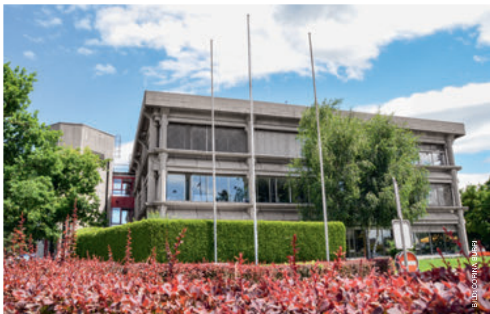
Im Untergeschoss des Verwaltungsgebäudes stehen Umbauarbeiten an.
